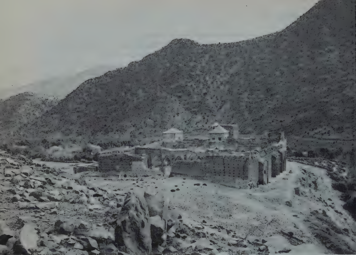
Mosquée de Tinnel dans le Haut Atlas. Vue d'ensemble et site.
